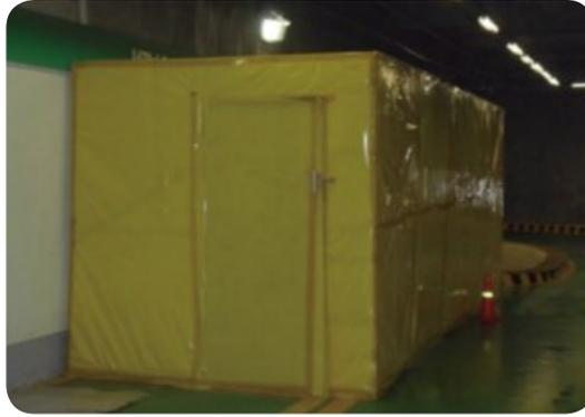
[그림 10-8] 석면폐기물 별도 보관장소 설치 예시
