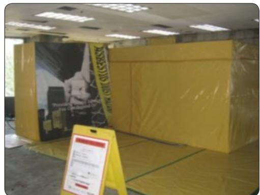
[그림 10-7] 위생설비 측면에 설치한 석면폐기물 반출구 예시
