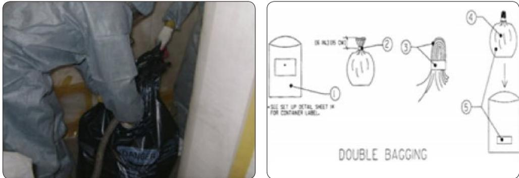
[그림 10-11] 폐슬레이트 상차 모습
