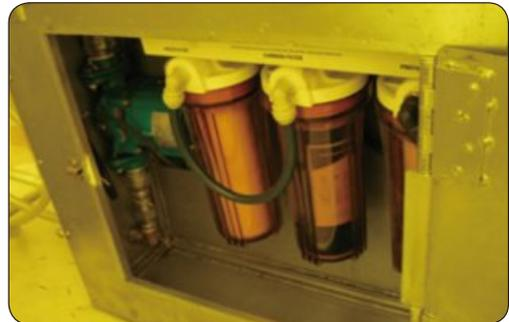
[그림 5-5] 냉온수기 및 배수여과장치 설치 예
